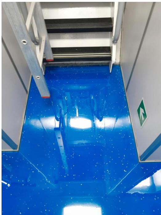
Pisos de membrana de poliuretano
